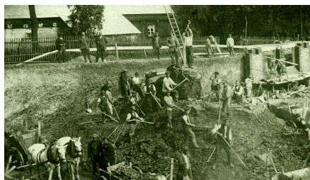
Tři záběry z výstavby nové továrny firmy J. Frank Rossbach
