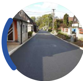
Oprava komunikace Na Vyhliďce I
