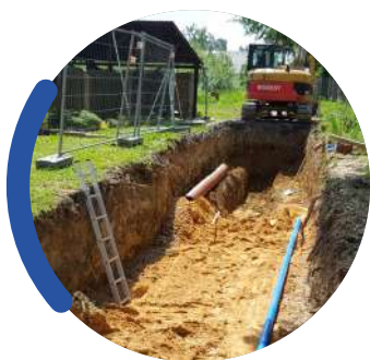
Rozšíření vodovodu a kanalizace
